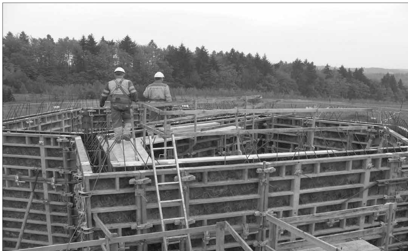
Stavba vodojemu v Babicích, foto: archiv
